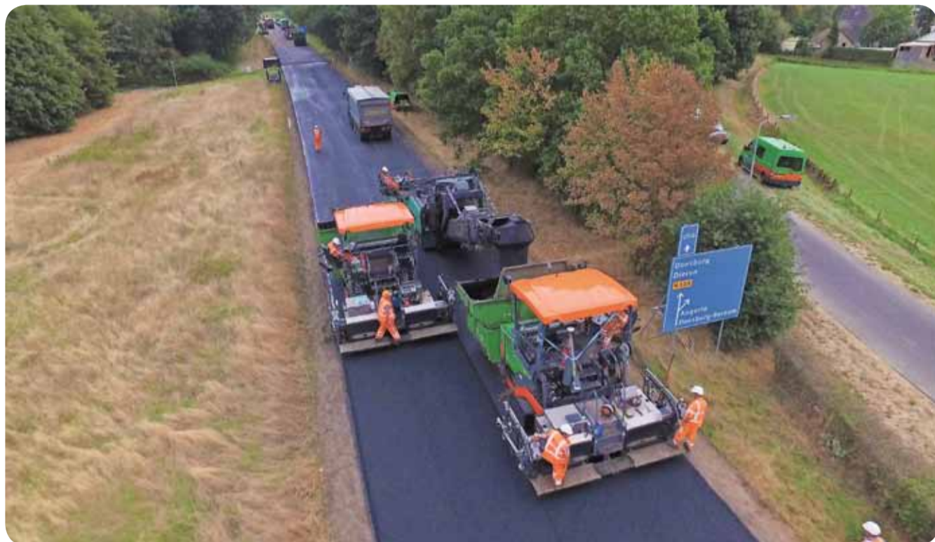
BAM heeft in Doesburg dubbellaags zoab aangelegd dat voor maximaal 93 procent bestaat uit gerecycled materiaal.
