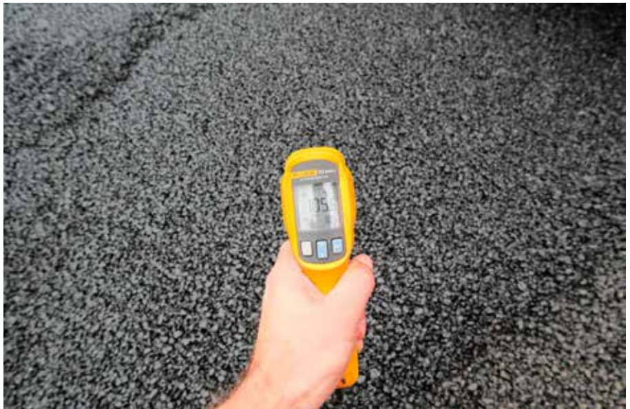
Het aflezen van de asfalttemperatuur.
